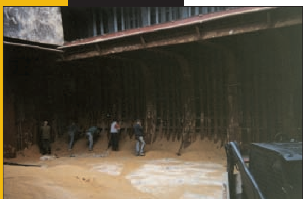
Nantes, déchargement de sucre, coll. Zimmer.
