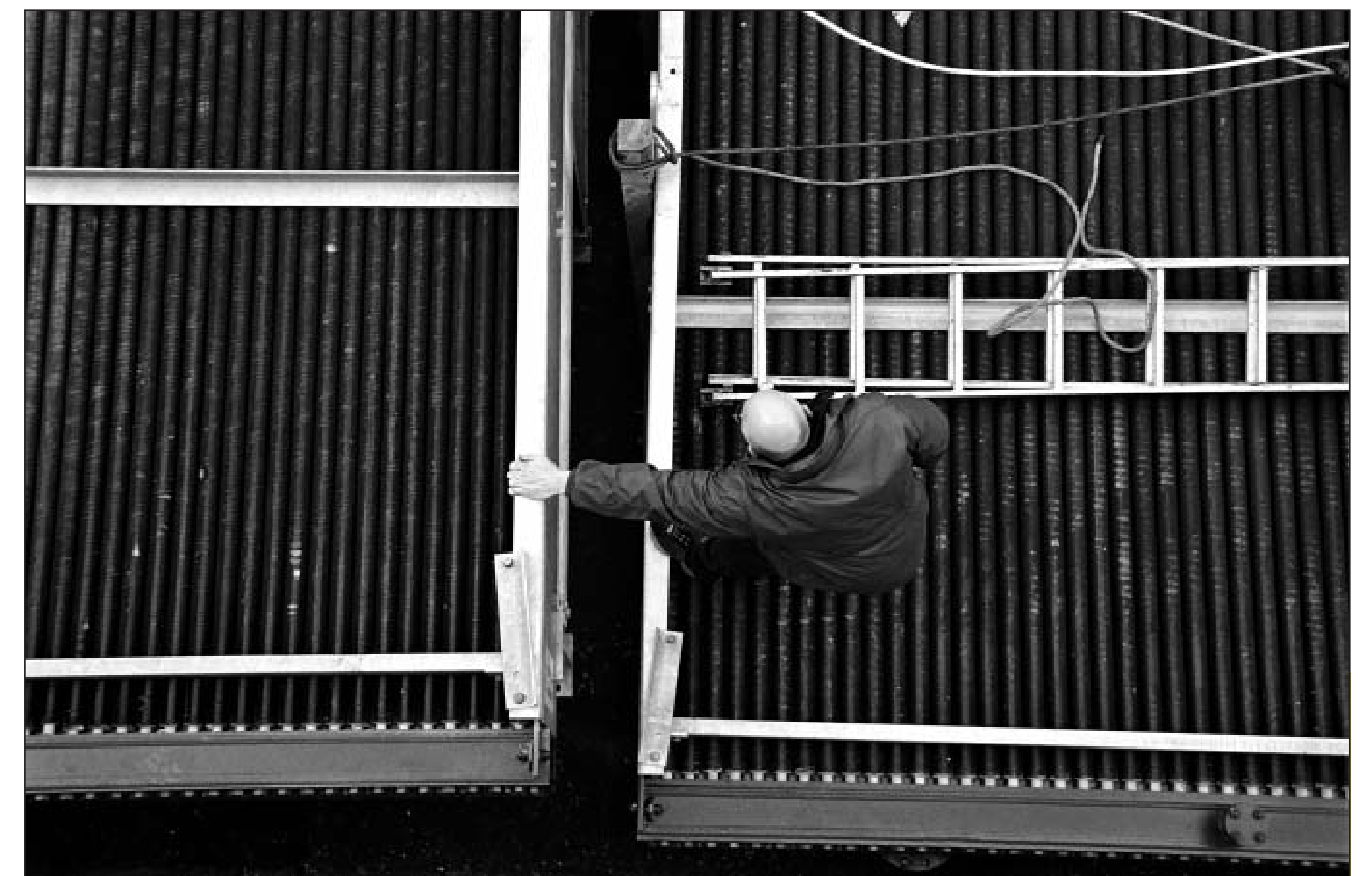
Terminal MDC de Montoir, coll. Bazin.
