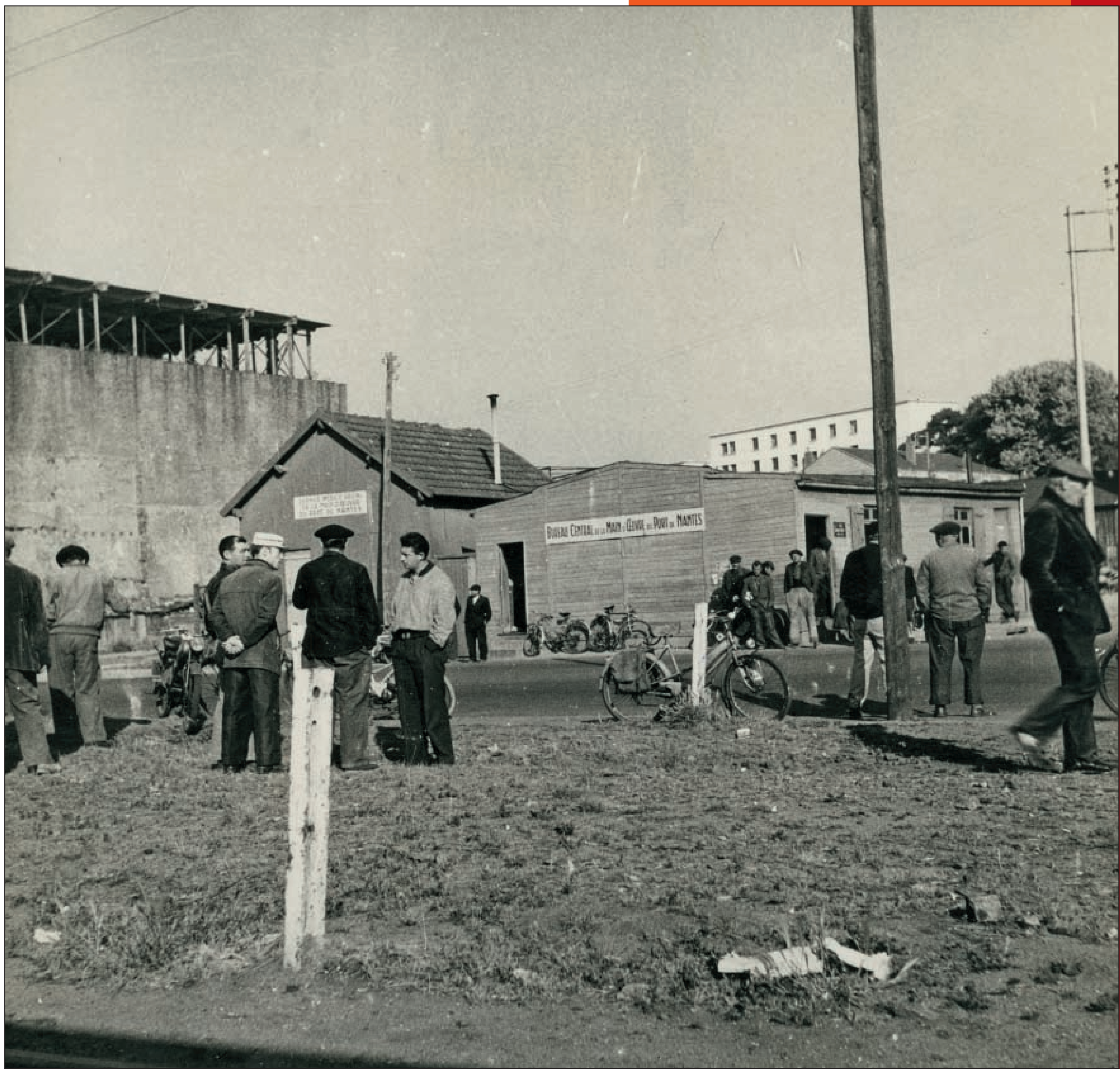
Nantes, bâtiment du BCMO, coll. Rousselot.
